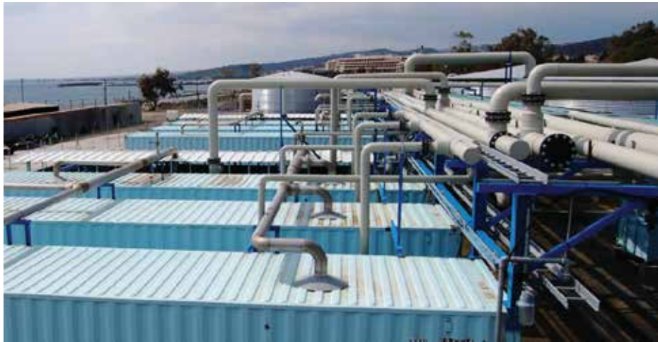
图1. 从控制室内拍摄海水淡化装置的照片 Subsea基础设施有限公司提供
